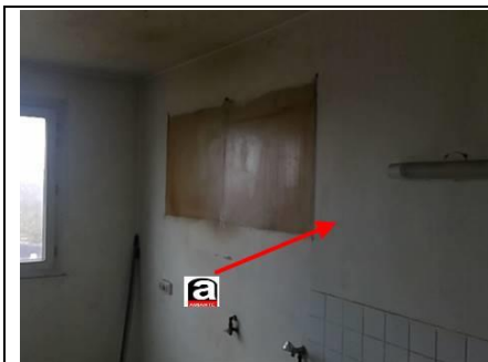
Photo n° PhA002 Localisation : Cuisine Ouvrage : 3 - Parois verticales intérieures - Murs et cloisons maçonnés Partie d'ouvrage : Enduit à base de plâtre lissé ou taloché Description : Enduit à base de plâtre lissé ou taloché
